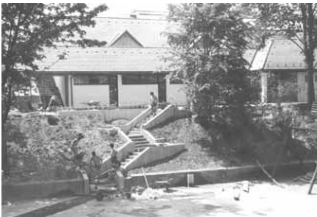
Bau der Turnhalle 1984
